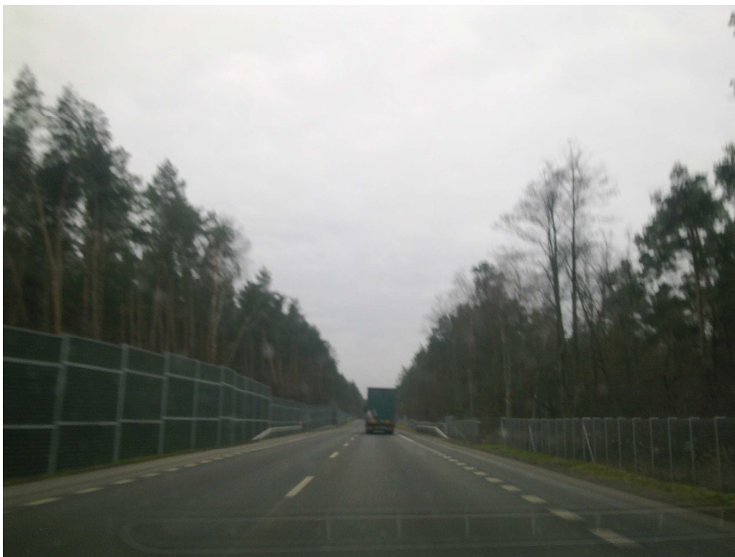
Fot.1 widok na fragment obszaru – pas terenu przyległy /po prawej stronie/ do drogi wojewódzkiej – obwodnicy Mielca, po lewej widoczny ekran akustyczny ograniczający MKG OChK
